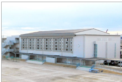
屋内運動場・プール格技場
