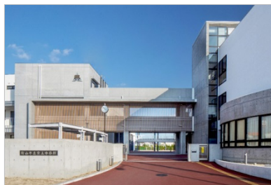
正門（渡り廊下を再生木ルーバーで囲いゲート化）
