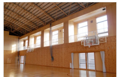
開口部を普通サッシとした屋内運動場内観
