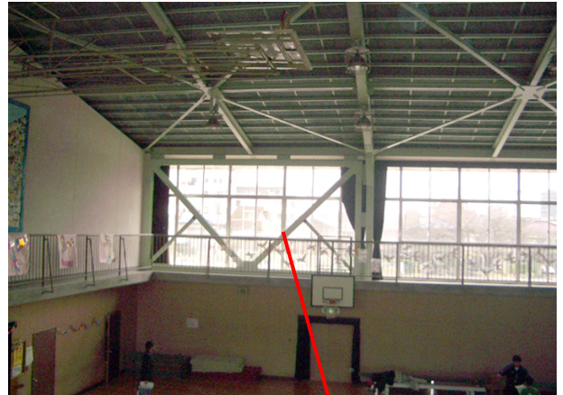
鉄骨ブレース
