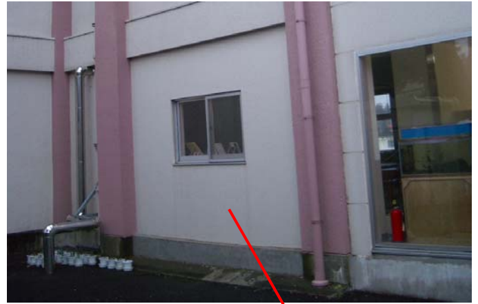
耐震壁の設置
