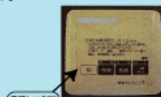
長押しでOFF 長く押さないとOFFにならないスイッチ
