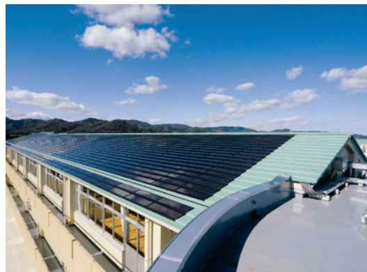
校舎屋根に40kWの太陽光パネルを設置 (静岡県湖西市立岡崎中学校)
