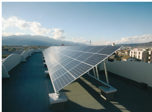
校舎屋上に20kWの太陽光パネルを設置 (山梨県甲府市立貢川小学校)
