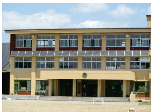
校舎壁面に3.2kWの太陽光パネルを設置 (福島県北塩原村立さくら小学校)
