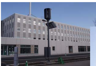
設置された縦軸貫流型エコ風力発電装置
