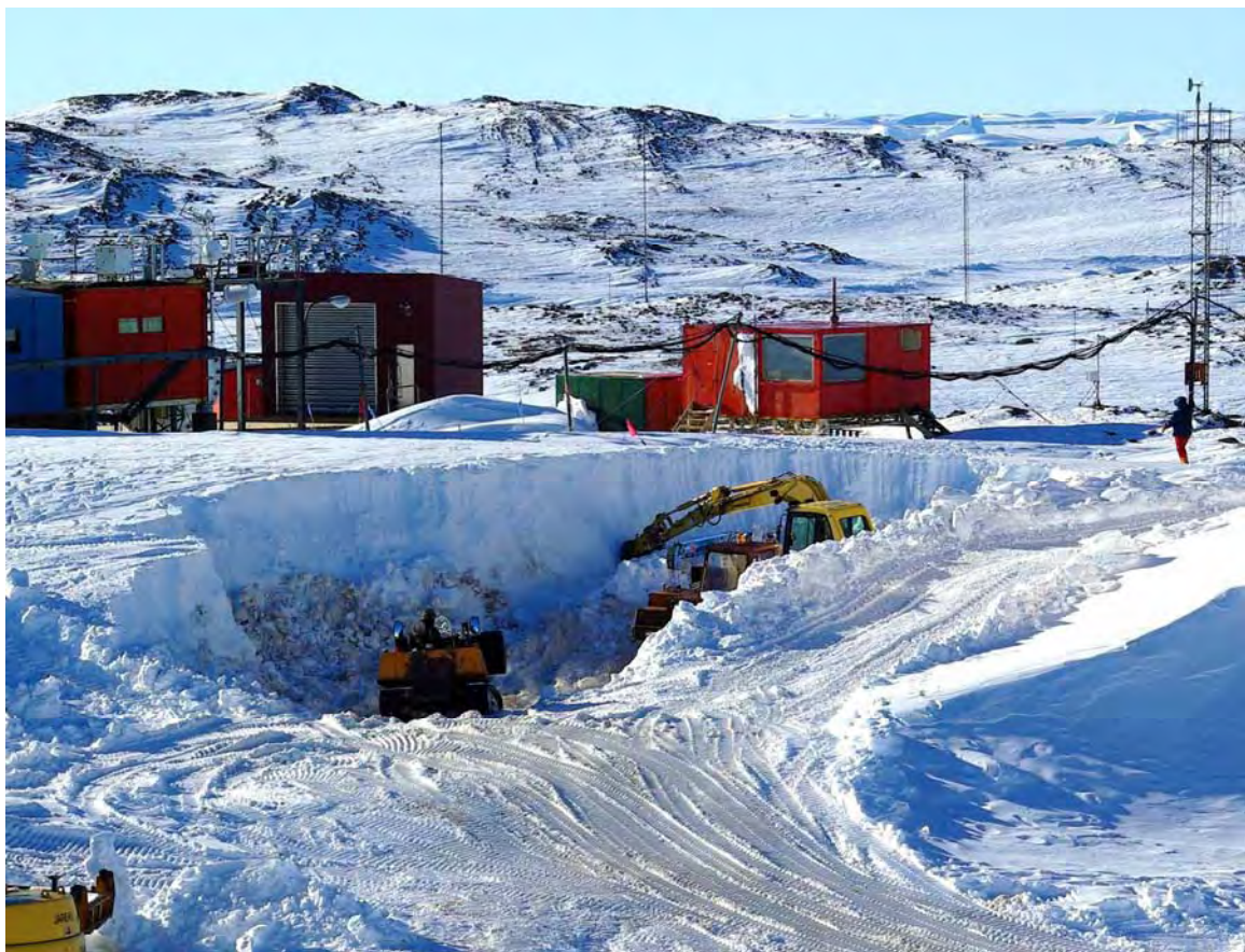
写真2： 昭和基地の除雪作業。
