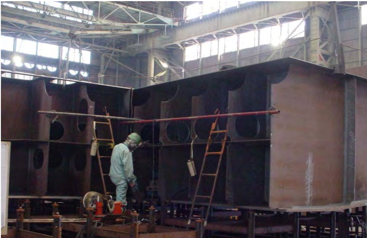
ブロック組立(二重底部)
