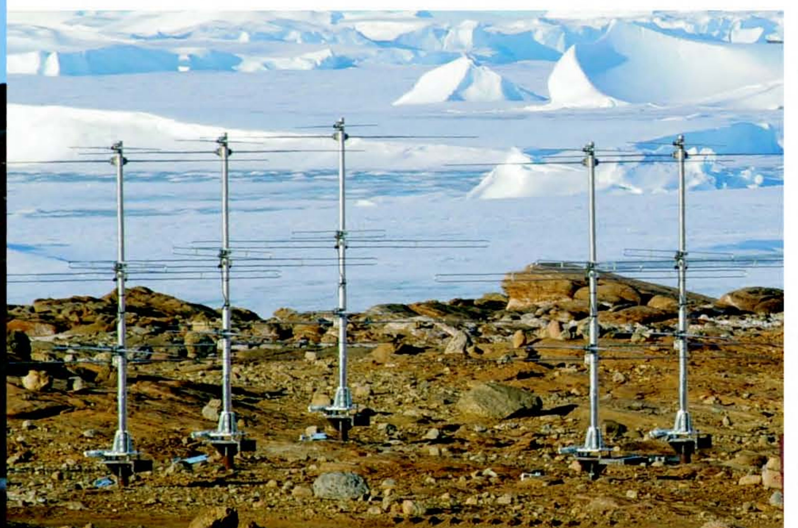
下部熱圏探査レーダー本体の設置を待つレーダー小屋とアンテナ群：第50次隊から稼働を始める。(昭和基地)
